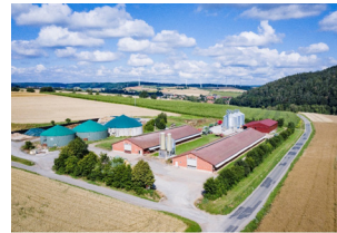
Biogasanlage „Bayern Süd“
